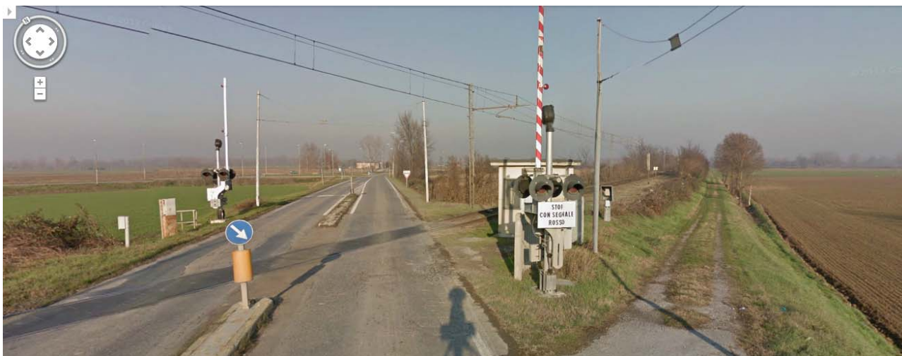
Figura 3. Foto dell'attraversamento stradale del PLA km 65+637 nel senso della corrente veicolare dal centro abitato di Bozzolo verso la SP10. È evidente la presenza, nell'immediata prossimità del PLA, di un cordolo rilevato in cemento che separa le due carreggiate (fonte: Google street viewer)
