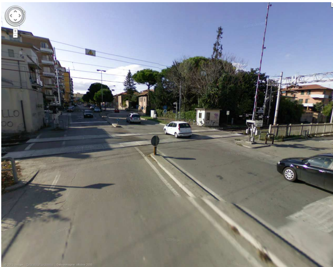
Figura 3. Foto dell'attraversamento stradale del PLA km 73+423 nel senso della corrente veicolare dalla periferia verso il centro città. È evidente l'esistenza del cordolo rilevato in cemento che separa le due carreggiate (fonte: Google street viewer)
