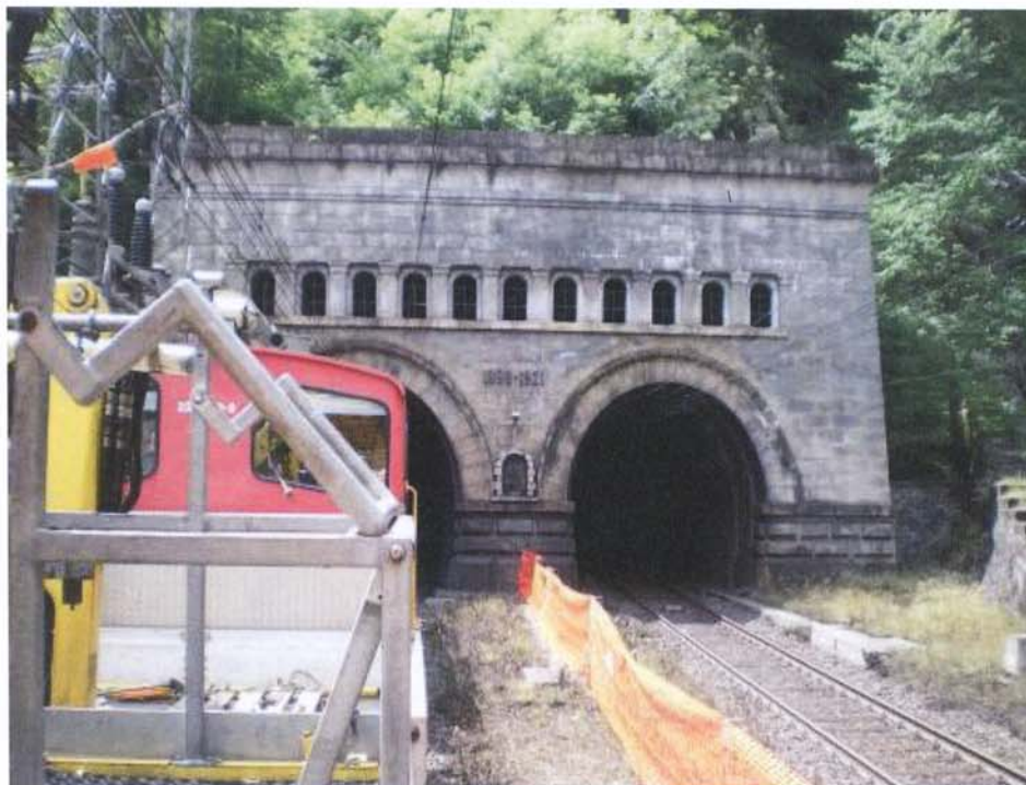
Figura 5 - Imbocco della galleria lato Iselle
