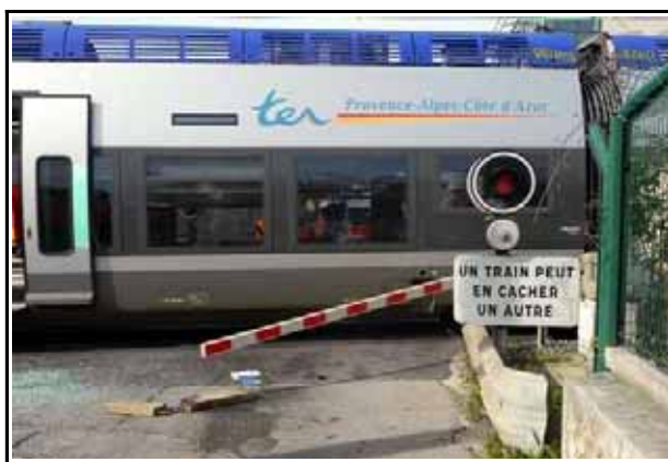
Figure 15 : Vue n° 4 - Le passage à niveau, vu du côté de l'allée des Grillons. La demi-barrière est pliée vers l'extérieur de ce passage à niveau.
