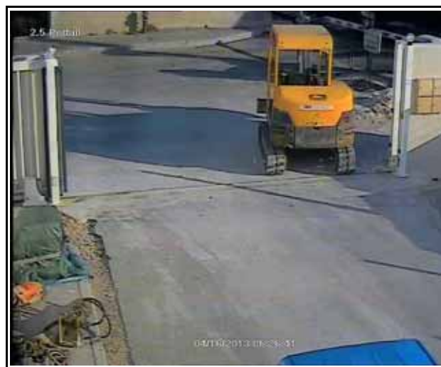
Figure 44 : Vue du portail à T0+01''
