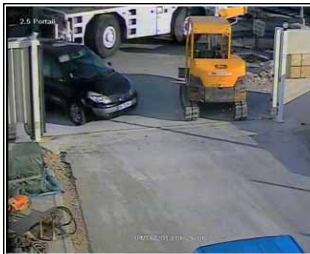
Figure 32 : Vue du portail à T0-33''
