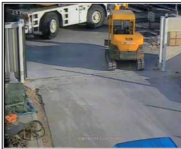
Figure 30 : Vue du portail à T0-45''
