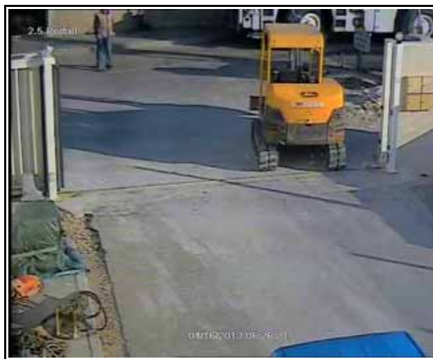
Figure 38 : Vue du portail à T0-19''
