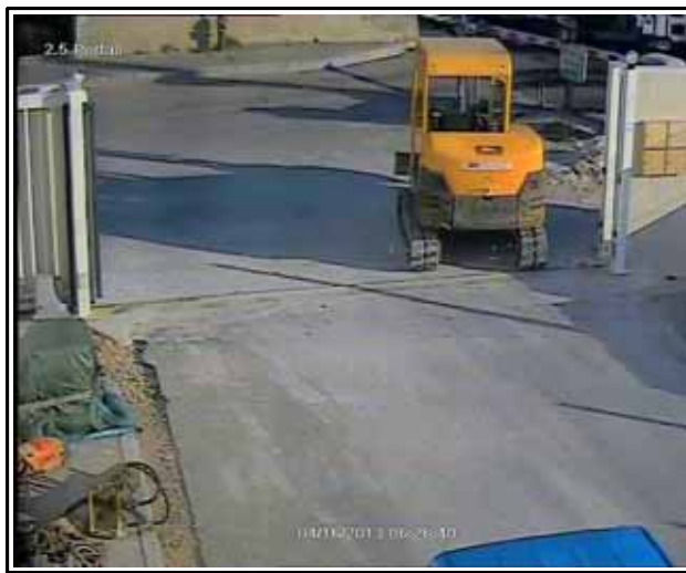
Figure 42 : Vue du portail à T0
