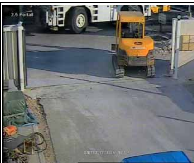
Figure 36 : Vue du portail à T0-28''
