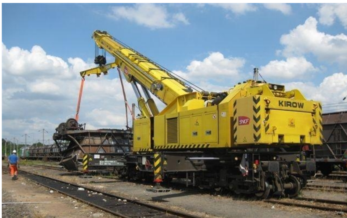
Illustration 2 : Opérations de relevage des wagons
