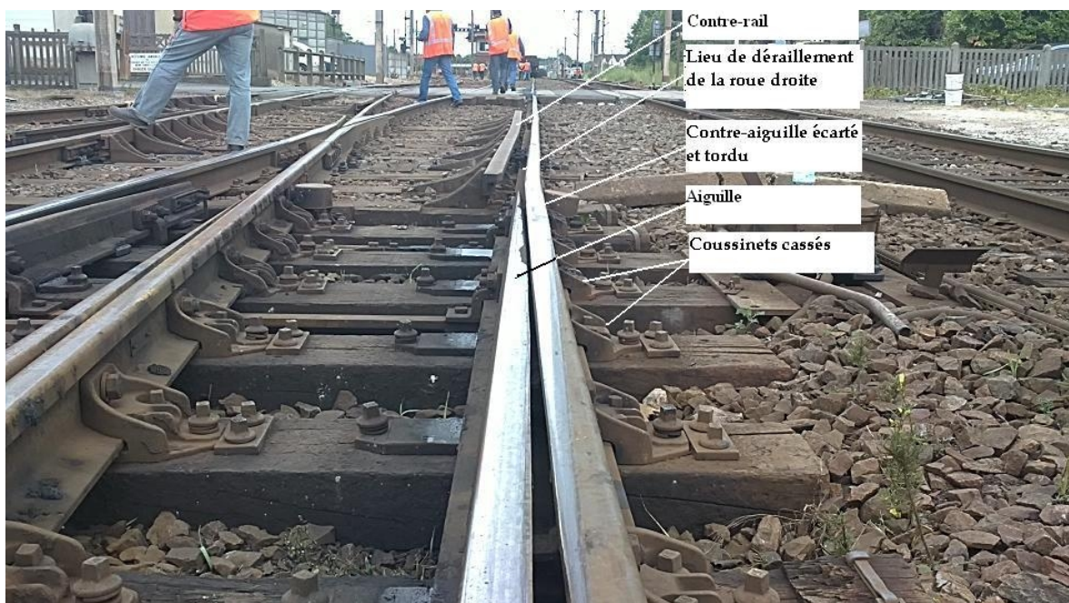
Illustration 17 : Vue de l'aiguille et du contre-aiguille
