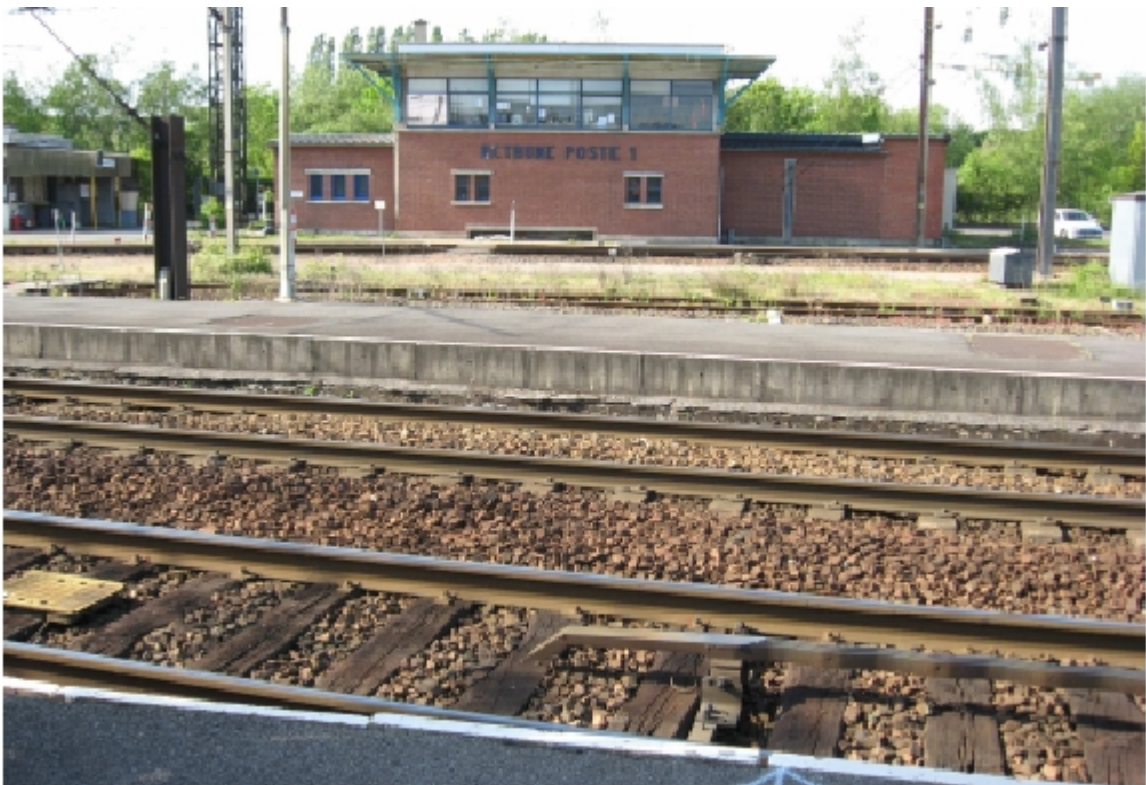
Illustration 23 : Vue du Poste 1 de Béthune ; la voie 2 est au premier plan
