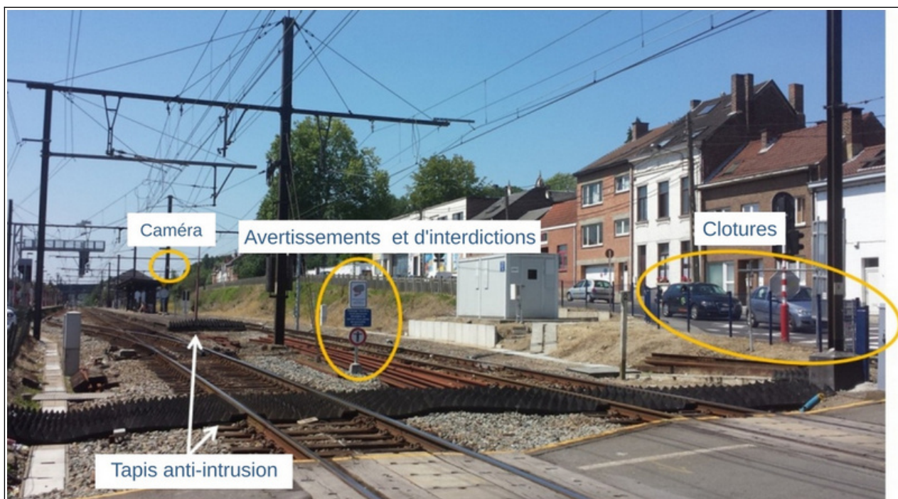
Vue 21 : une utilisation en Belgique
