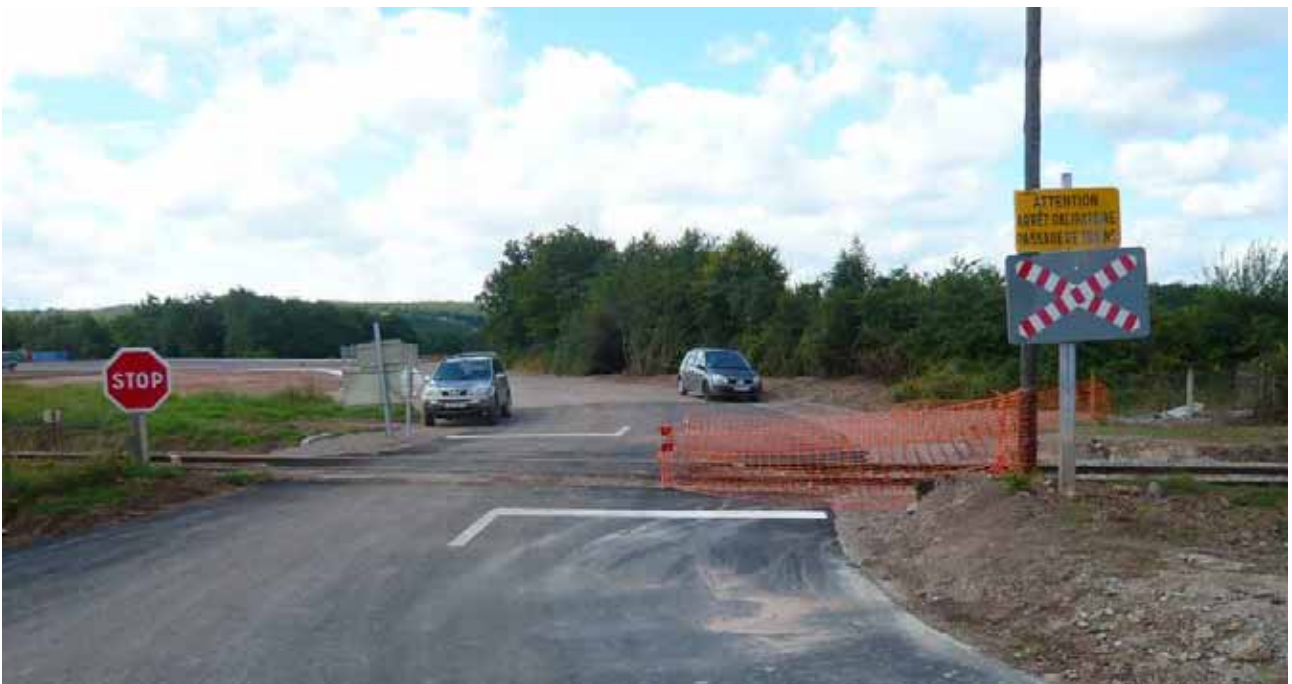
Photo n° 6 : Le passage à niveau trois mois après l'accident. La chaussée a été élargie et bitumée. Les lignes blanches au sol ont été ajoutées. Il manque un « Stop » à droite.
