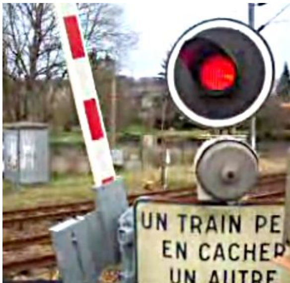
Figure 2 : barrière, feu rouge R24 et sonnerie
