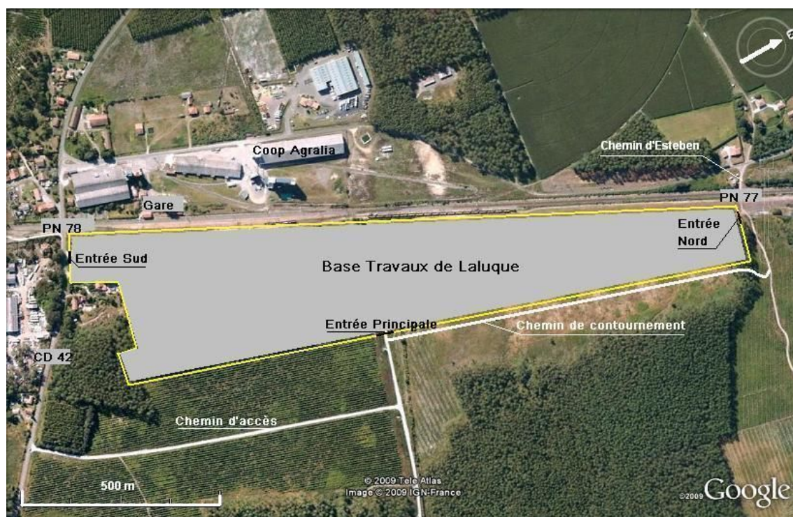
Figure 5 : vue générale de la base et des accès
