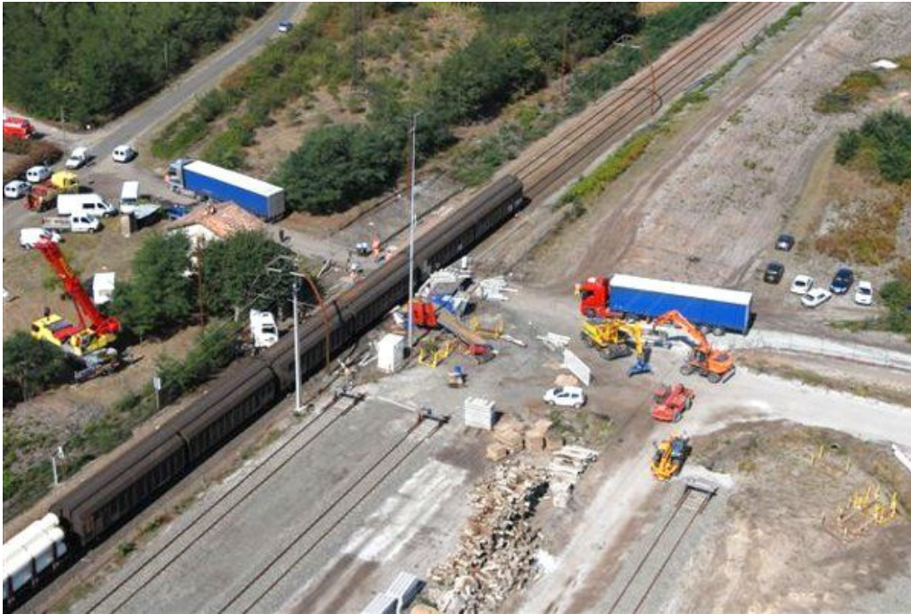
Figure 16 : vue générale après l'accident
