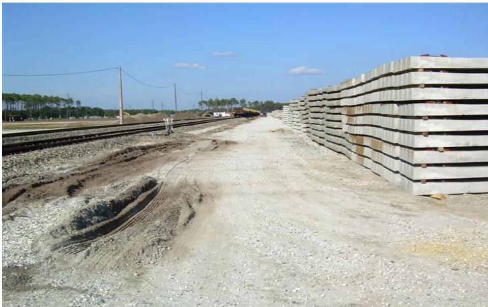
Figure 13 : la piste principale avec le stockage provisoire de traverses à droite et les traces d'enlèvement du camion à gauche
