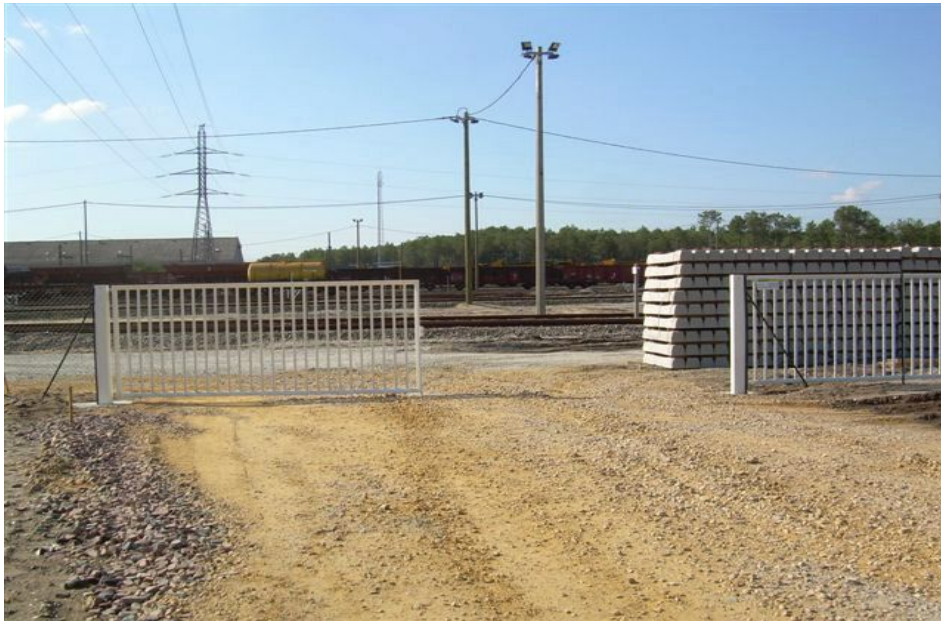
Figure 12 : vue du portail principal et du stockage provisoire de traverses
