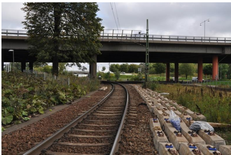
Figur 10. Fotografi taget i motsatt riktning till figur 9. Enligt SHK:s egna mätningar på olycksplatsen några dagar efter händelsen befann sig åtminstone innersta raden av dessa sliprar inom säkerhetszonen.
