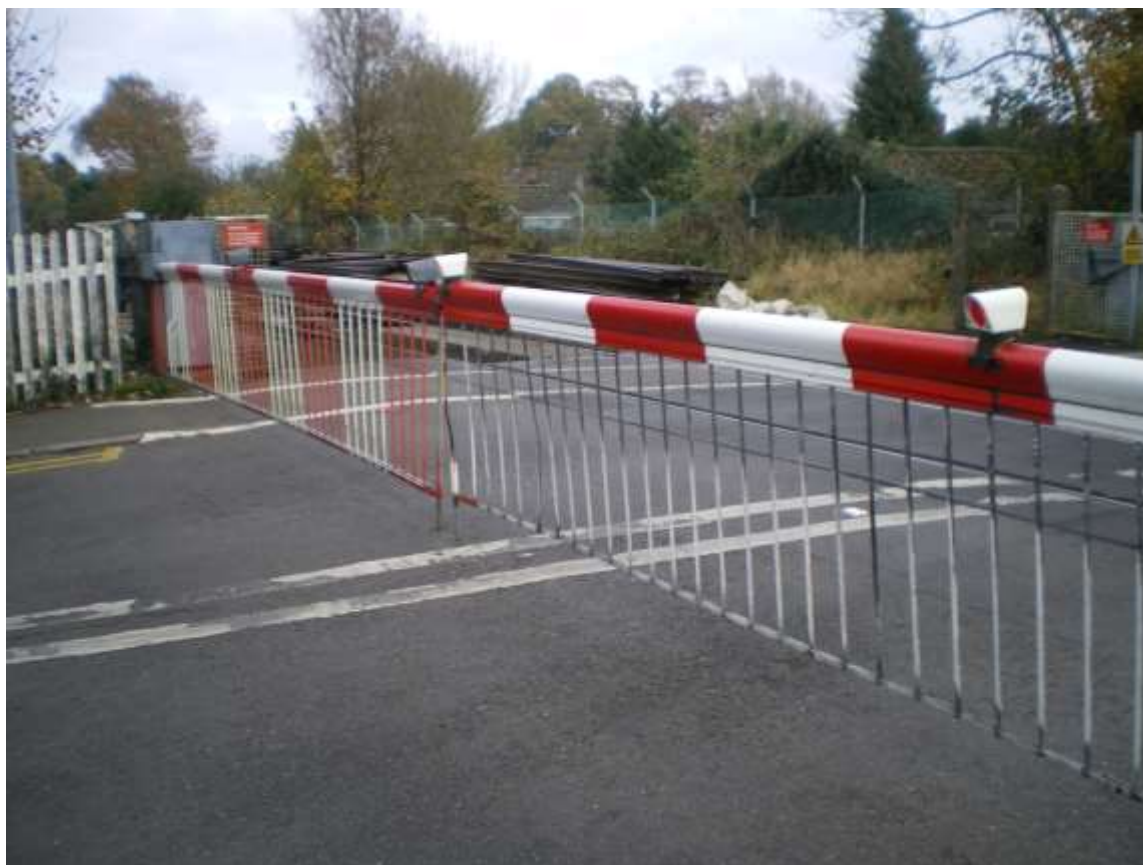
Foto n. 31 - Esempio di PLA con grebbiali utilizzato nel Regno Unito.
