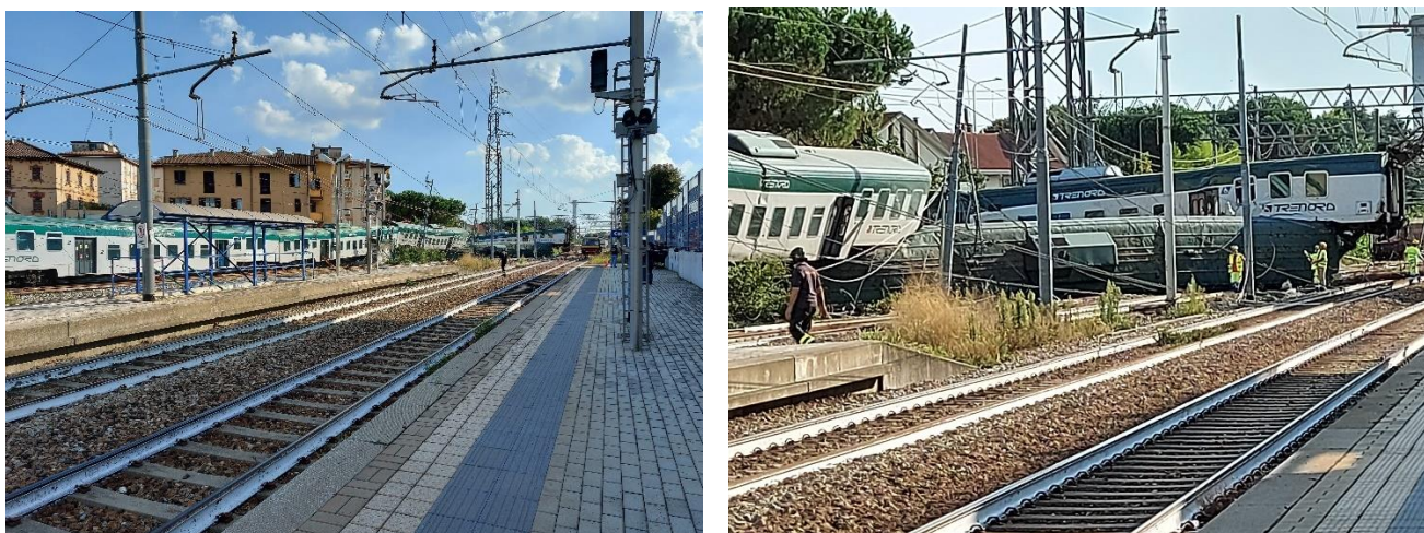
Figure 16 e 17 – sopralluogo sul sito dell'incidente (fonte: DiGIFeMa)
