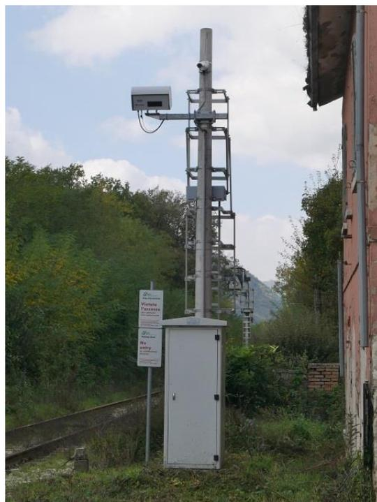
**Figura 66 - Dispositivi PAI-PL installati ai PL Km 5+789 (foto sx) e PL Km 8+133 (foto dx)**
