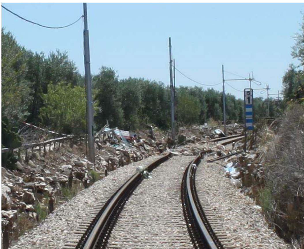
Figura 4 - Punto di collisione (km 51)
