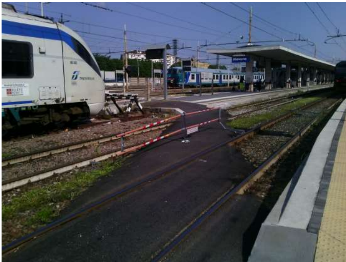
Foto n. 16 - Stazione di Novara - barriere verticali temporanee a protezione area di cantiere (maggio 2016)
