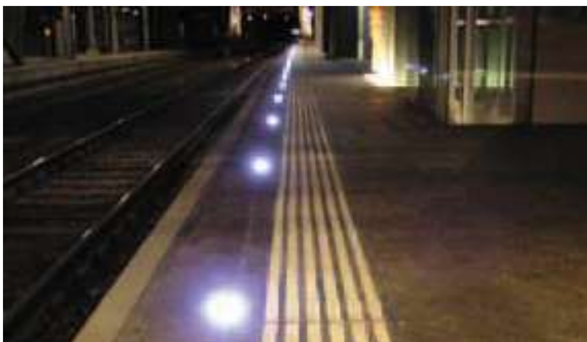
Foto n. 11a - Esempio di delineatori di margine a LED per banchine ferroviarie
