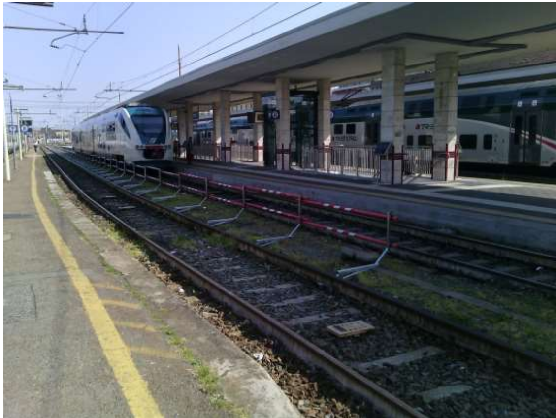
Foto n. 15 - Stazione di Novara - barriere verticali temporanee a protezione area di cantiere (maggio 2016)
