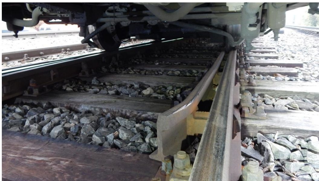
6. ábra: a 6. sz. kitérő vezetősínjén lévő ütés- és felfutásnyom
