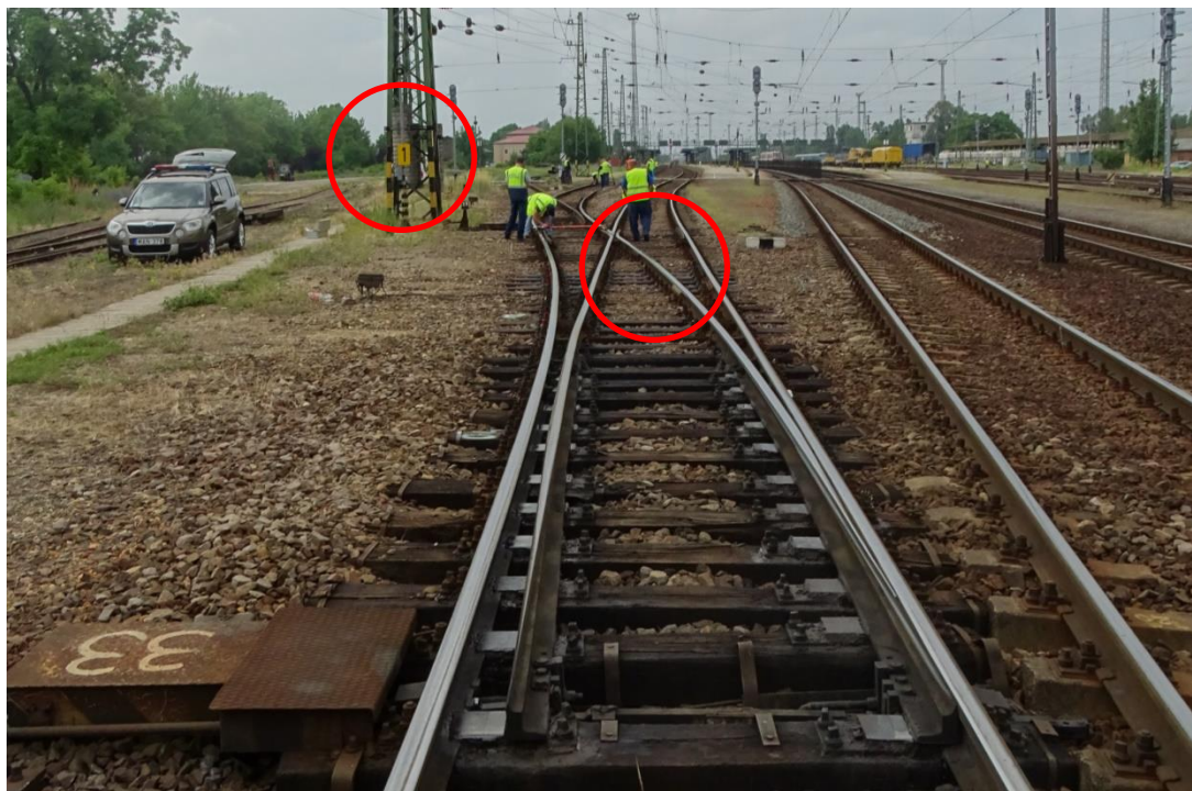
4. ábra: a sebességkorlátozás kezdete a hibás kitérő után
