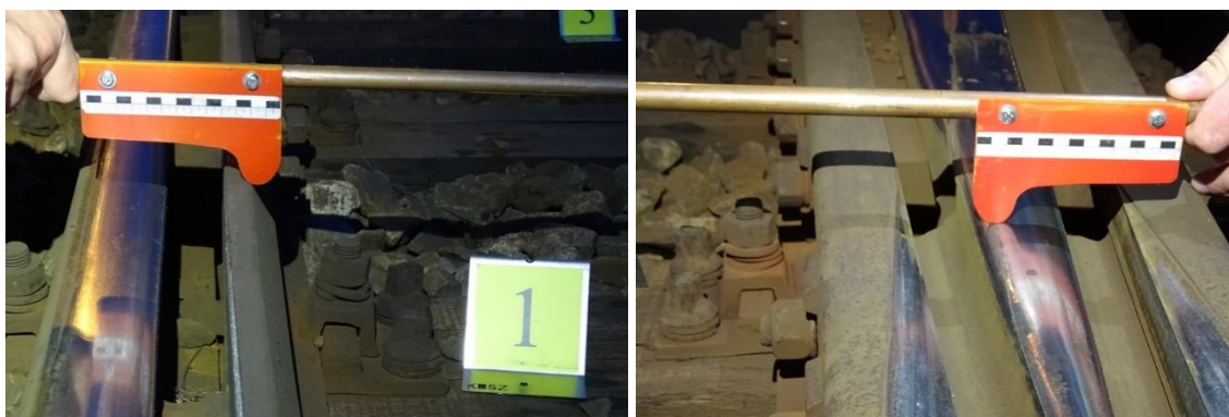
3. ábra: a kisiklott kerekek helyzete a keresztezési részen, a látható nyomok alapján
