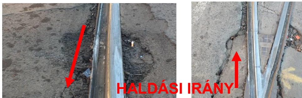
5. ábra: A nyomvályú hiánya és a keresztezési csúcs
