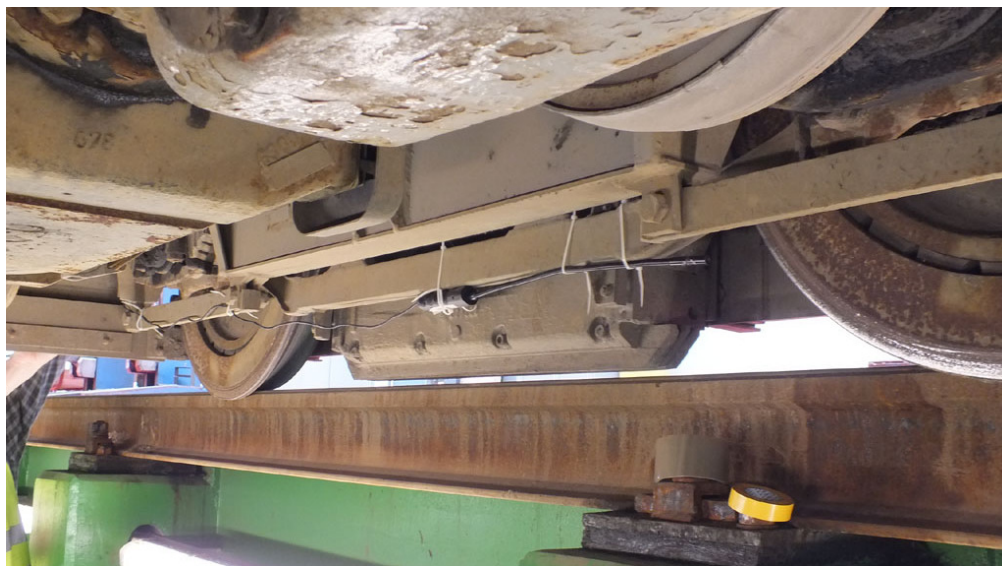
9. ábra: kamera elhelyezése a forgóvázon
