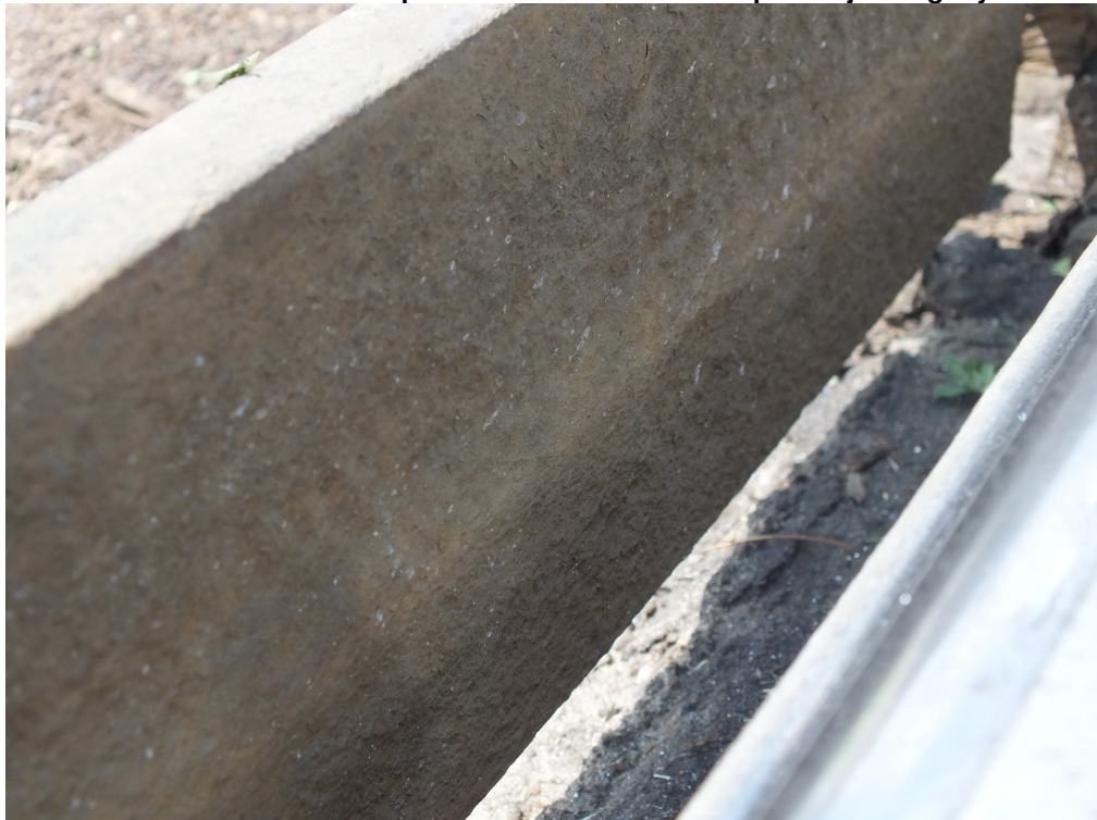
13. ábra: terelőelem a balesetben részes típussal nem járt vágányon
