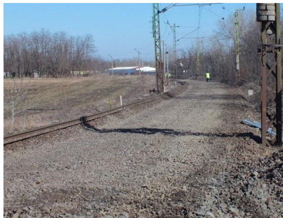
5. sz. ábra A vasúti pálya újjáépítése
