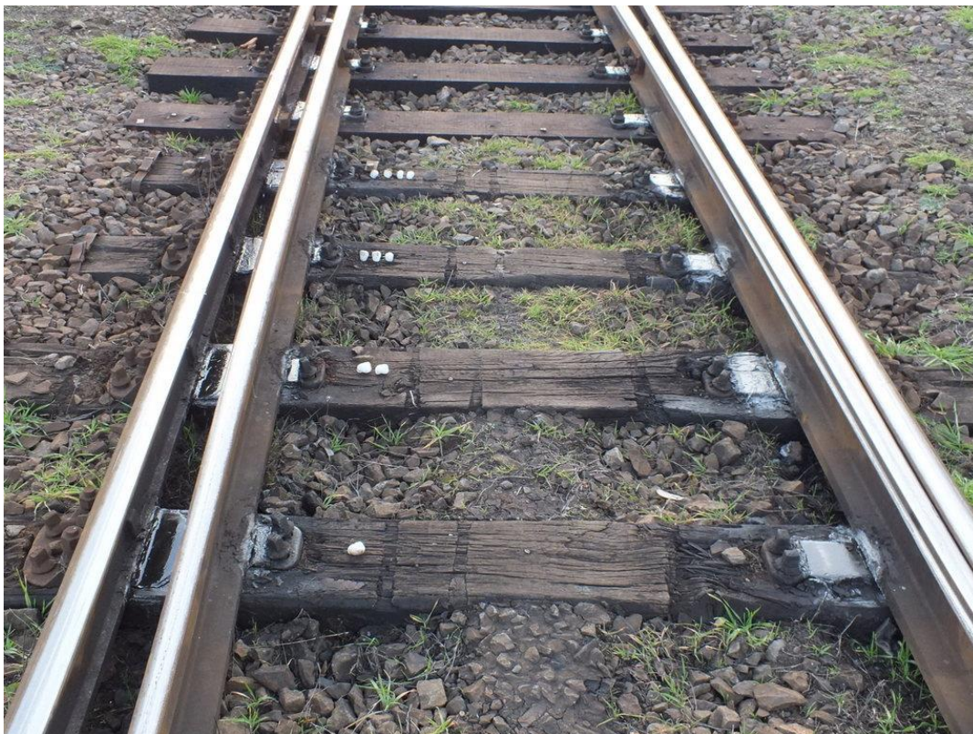
6. ábra: a 451. sz. kitérő alj-állaga a kisiklás környezetében (a kisiklás helye a két jelel ellátott alj bal sínszálánál van)
