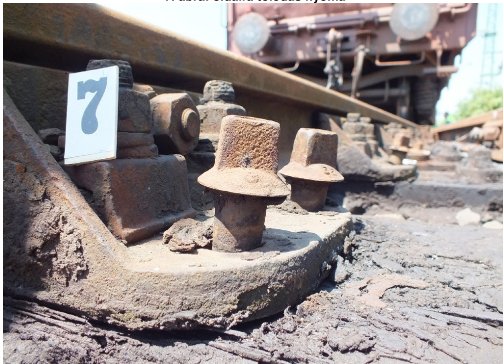
8. ábra: laza kapcsolószerek, szennyeződés a csavarok alatt
