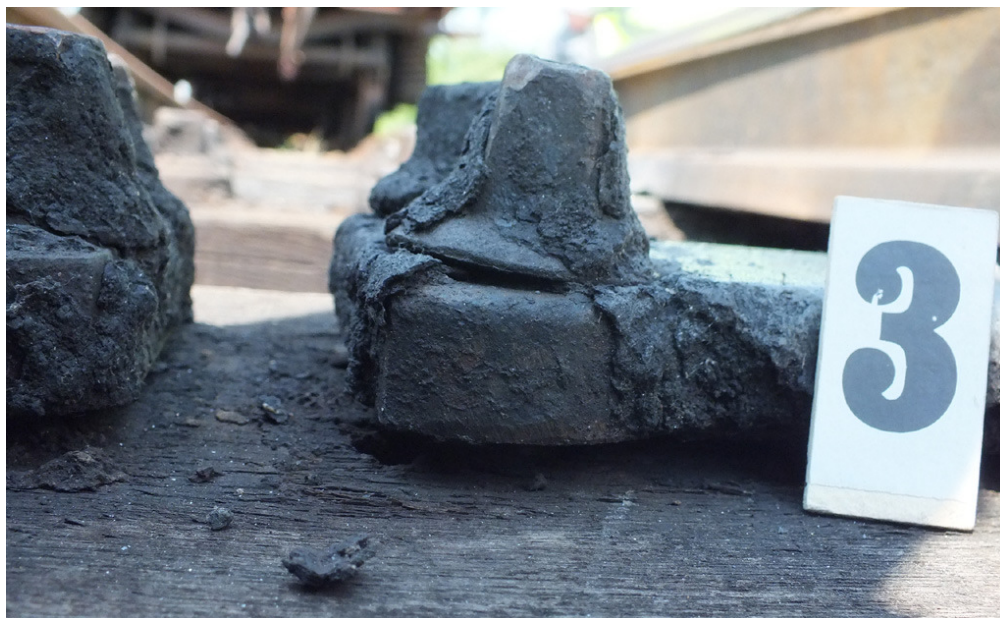
9. ábra: laza kapcsolószerek, szennyeződés a csavarok alatt
