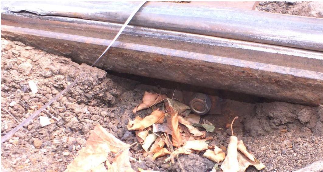
7. ábra: a rámpát oldalirányban rögzítő csavar
