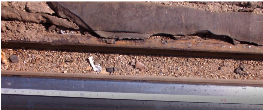
8. ábra: a bal sinszál tömítésének rongálódása (a mérőszalag 2 m-es beosztása van a nullponton)
