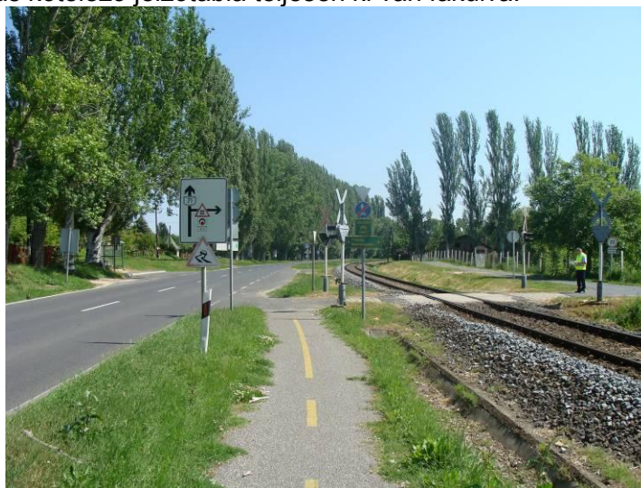
4. ábra: a kerékpárútról a vasúti átjáró megközelítése
