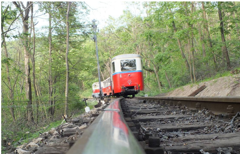
3. ábra: a kisiklás kezdete a bal illesztés előtt és a vonat
