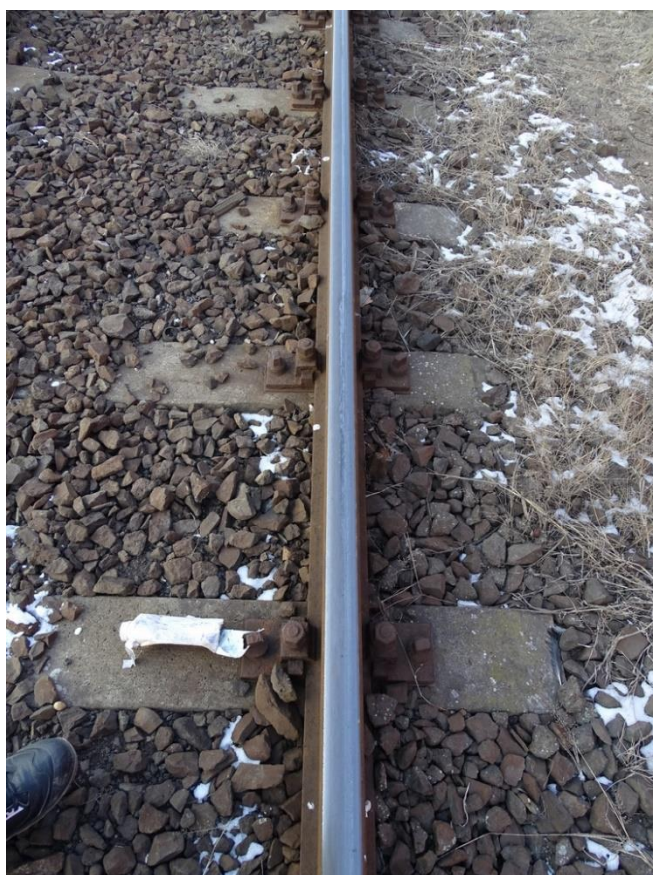
5. ábra: a sínen csúszó saru nyoma a vonat indulásának helyén
