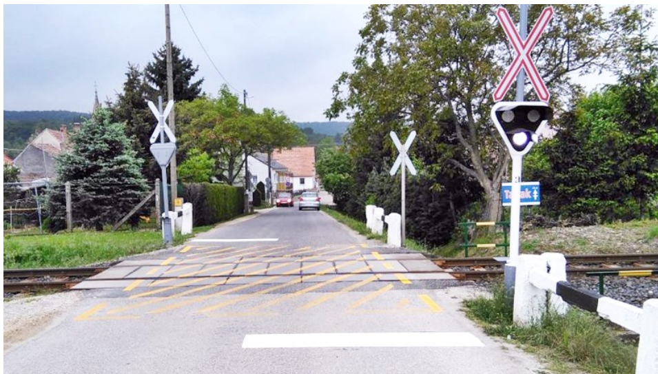
10.ábra: A szintbeli keresztezés az útburkolati jelek és a baloldali „Vasúti átjáró kezdete”-jelzőtábla elhelyezése után
