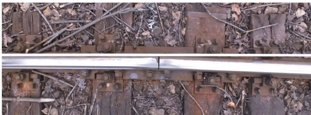
7. ábra: irányhiba és sínkopás (az illesztés a felkapás kezdete)
