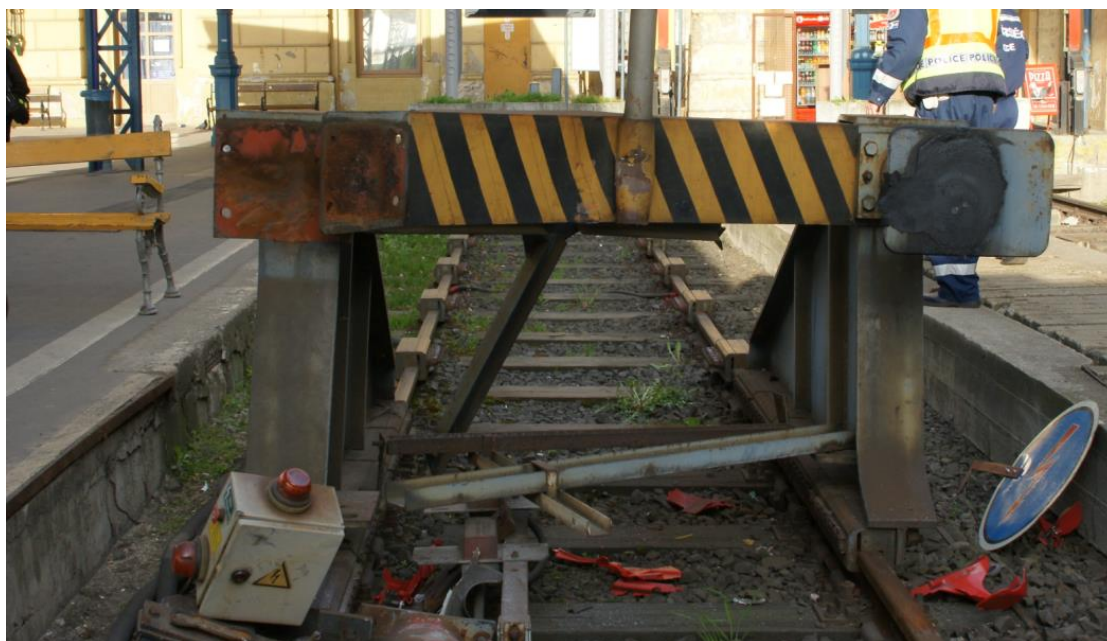
5. ábra: Az ütközőbak sérülései
