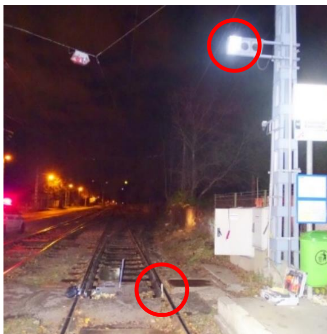
18. ábra: a váltójelző akadályozott állításánál
