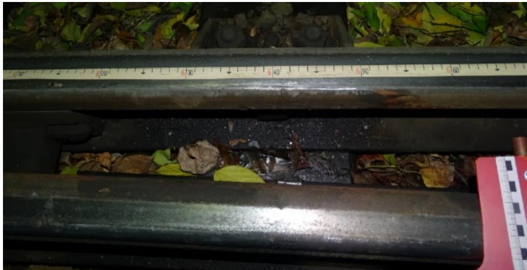
8. ábra: nyomok a bal tősinen októberben (a mérőszalag 1 m-es osztása van a csúcscsín hegyénél)
