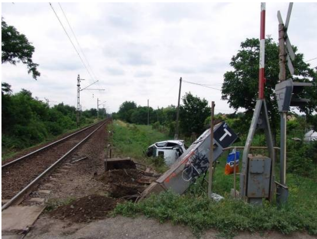
6. ábra: A kifordult sorompószerény
