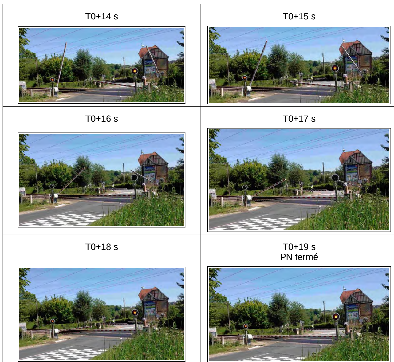
Figure 19 : mouvement des demi-barrières côté Barentin en fonction du temps (suite) (photos BEA-TT)
