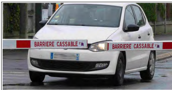
Figure 35 : exemple d'autocollants « barrière cassable » apposés sur les lisses (images BEA-TT sur le PN n° 8 de Roissy en Brie)
