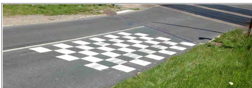
Figure 16 : damier implanté sur la voie de circulation (photo BEA-TT)
