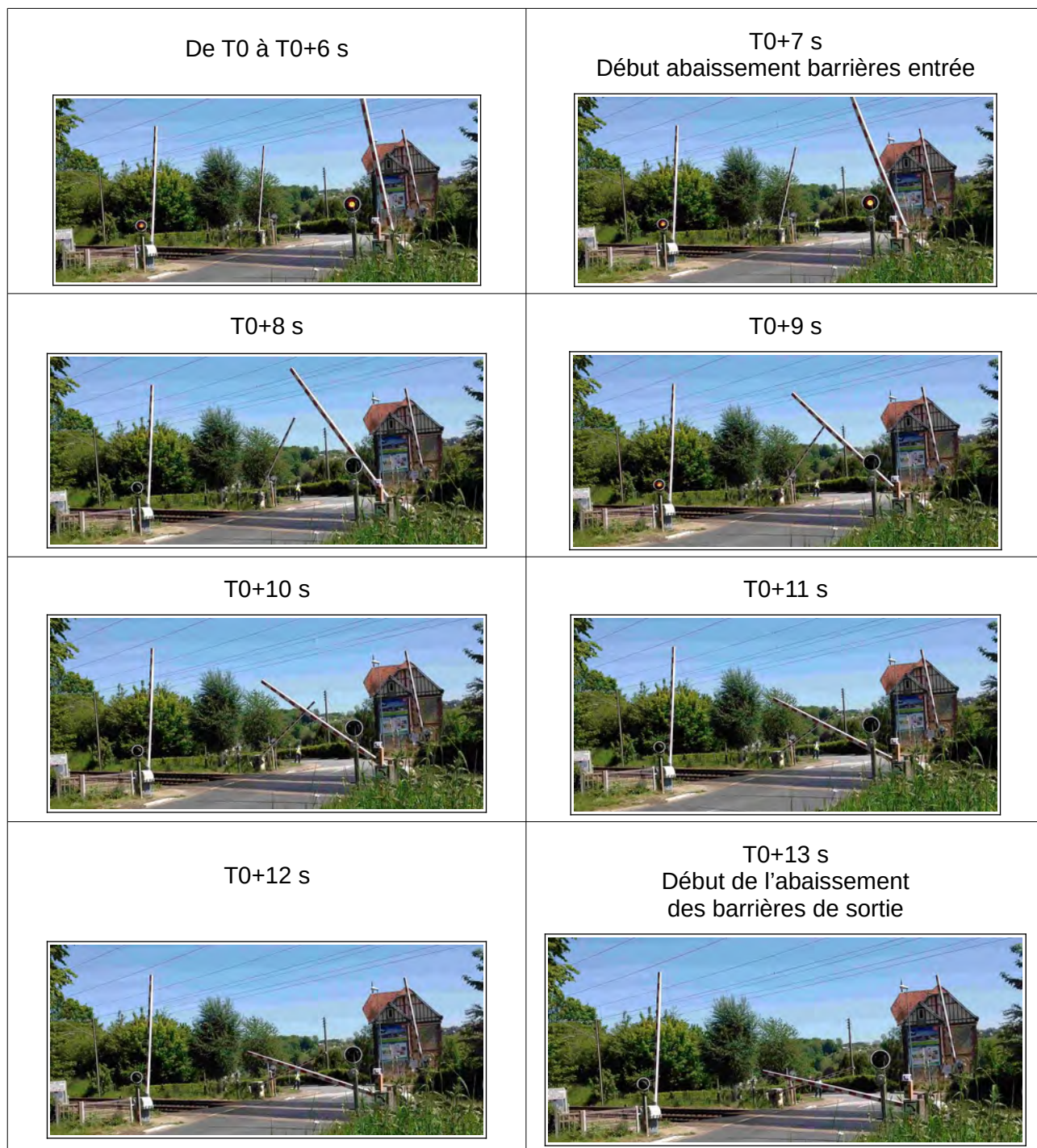
Figure 18 : mouvement des demi-barrières côté Barentin en fonction du temps (photos BEA-TT)
