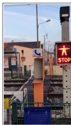
Figure 27 : illustrations de l'expérimentation d'alerte sonore au PN n° 29 de Bruyères-sur-Oise (photos prises par le BEA-TT)
