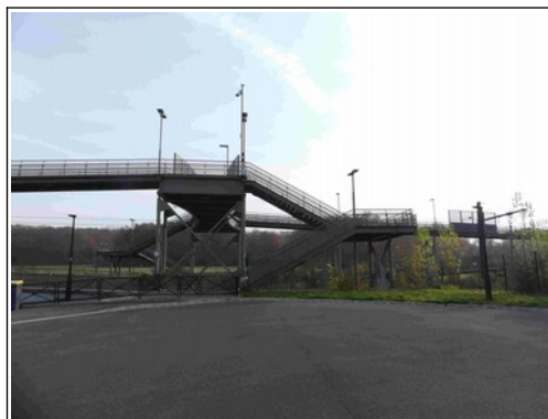
Passage supérieur, passerelle d'accès au collège
