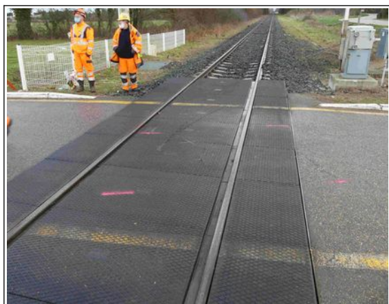
Figure 37 : identification des points de localisation des roues du VL au moment du choc photo Police nationale
