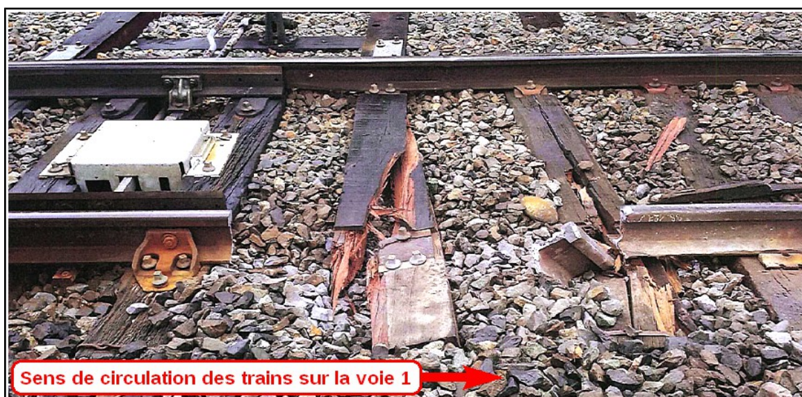
Fig. 1 : La lacune dans la file de droite de la voie 1
