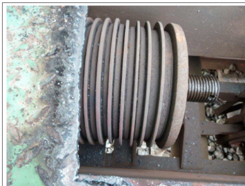
Figure 15 : Vue du bloc de traction de l'attelage rompu
