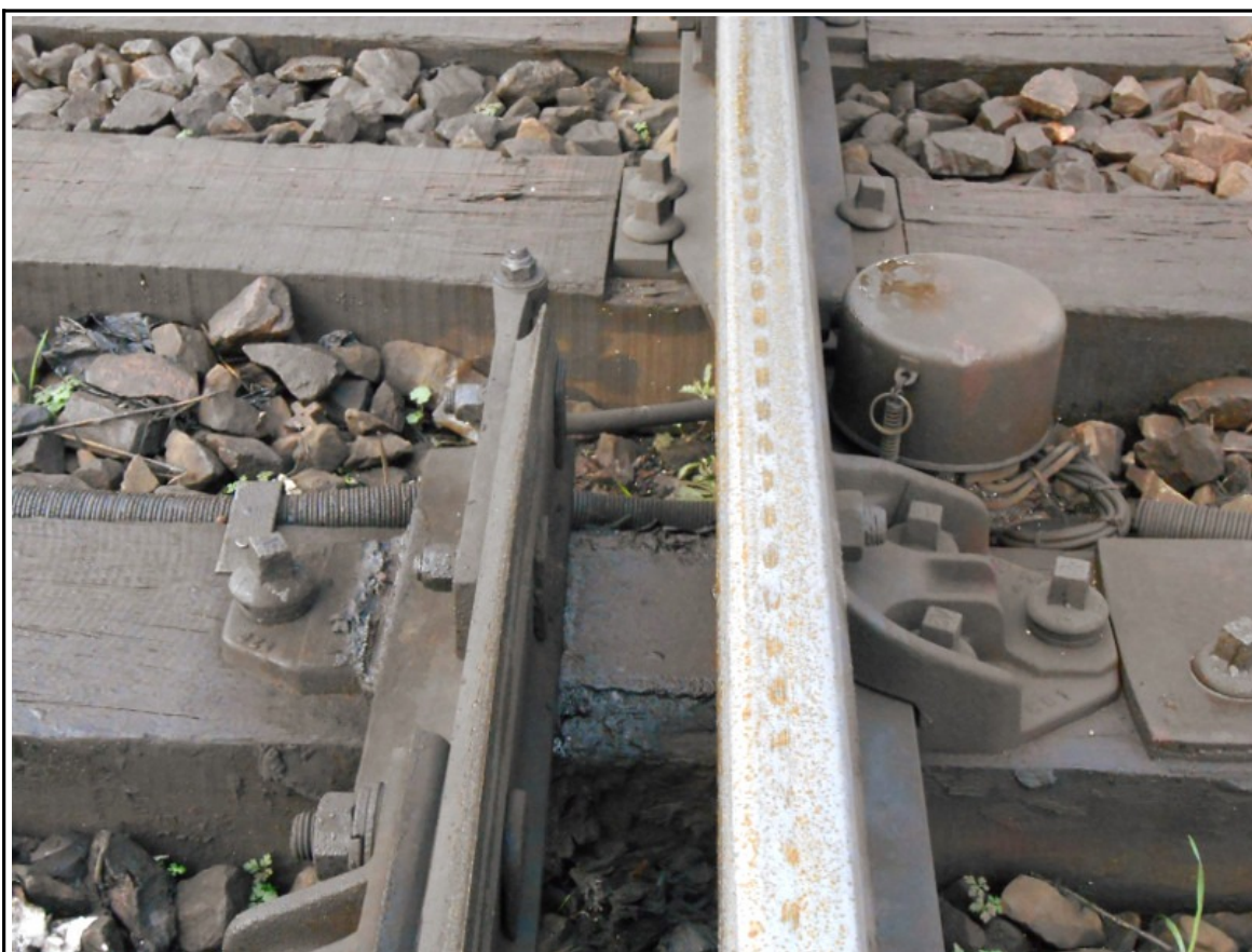
Figure 22 : Pointillés au niveau de la pointe du branchement B
