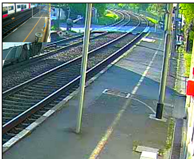
Figure 31 : À T0-6'47", un train de voyageur s'arrête à la gare de Nangis, à gauche sur la photo. Les barrières du PN sont fermées.
