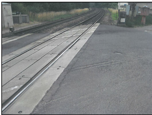
Figure 15 : Les traces d'arrachages constatées le 26 juin 2009. L'ensemble routier accidenté venait de droite et le train arrivait d'en face, sur la voie ferrée de droite.
