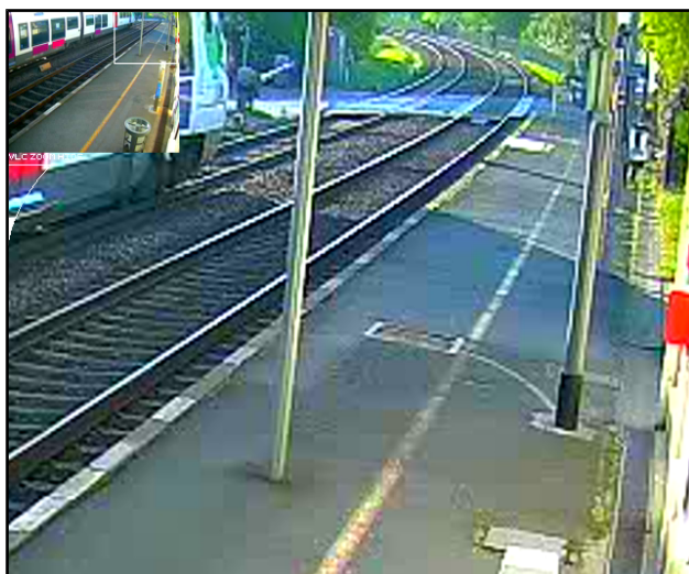
Figure 32 : À T0-6'01", le train de voyageur part de la gare de Nangis, à gauche sur la photo. Les barrières du PN sont fermées.
