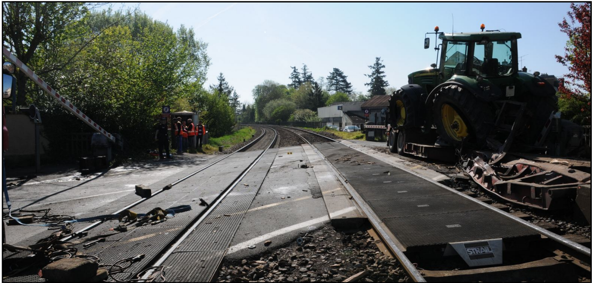
Figure 43 : Profil du passage à niveau au moment de l'accident. L'ensemble routier venait de droite.
