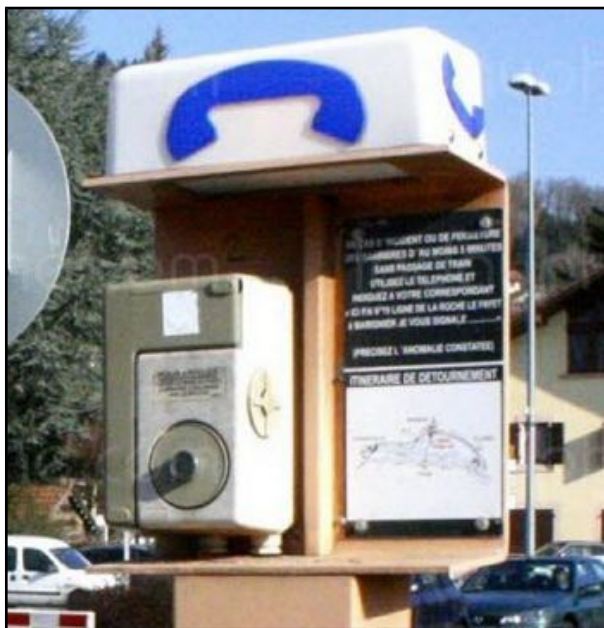
Figure 13 : Un téléphone de PN avec un support de type "autoroute".
