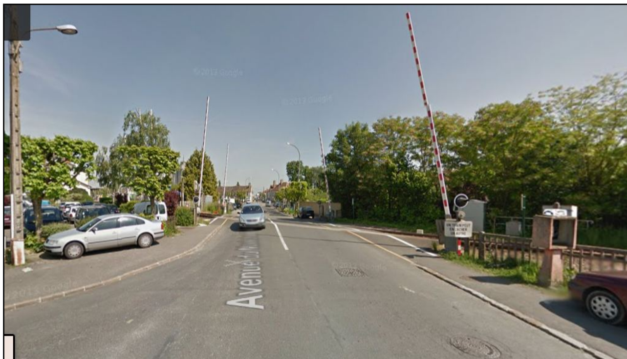
Figure 8 : L'arrivée sur le passage à niveau n° 41, dans le sens de circulation de l'ensemble routier accidenté. Le train arrivait de droite sur la première voie ferrée.
