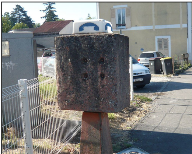
Figure 9 : Le coffret en béton contenant le téléphone du sens de circulation de l'ensemble routier accidenté. Vue depuis le passage à niveau.
