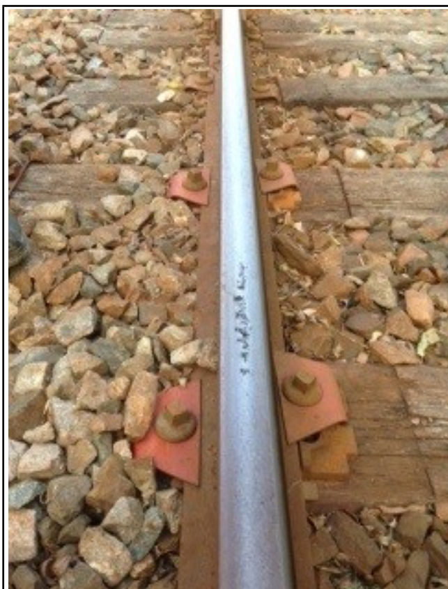
Figure 12 : Salissure ponctuelle du rail
