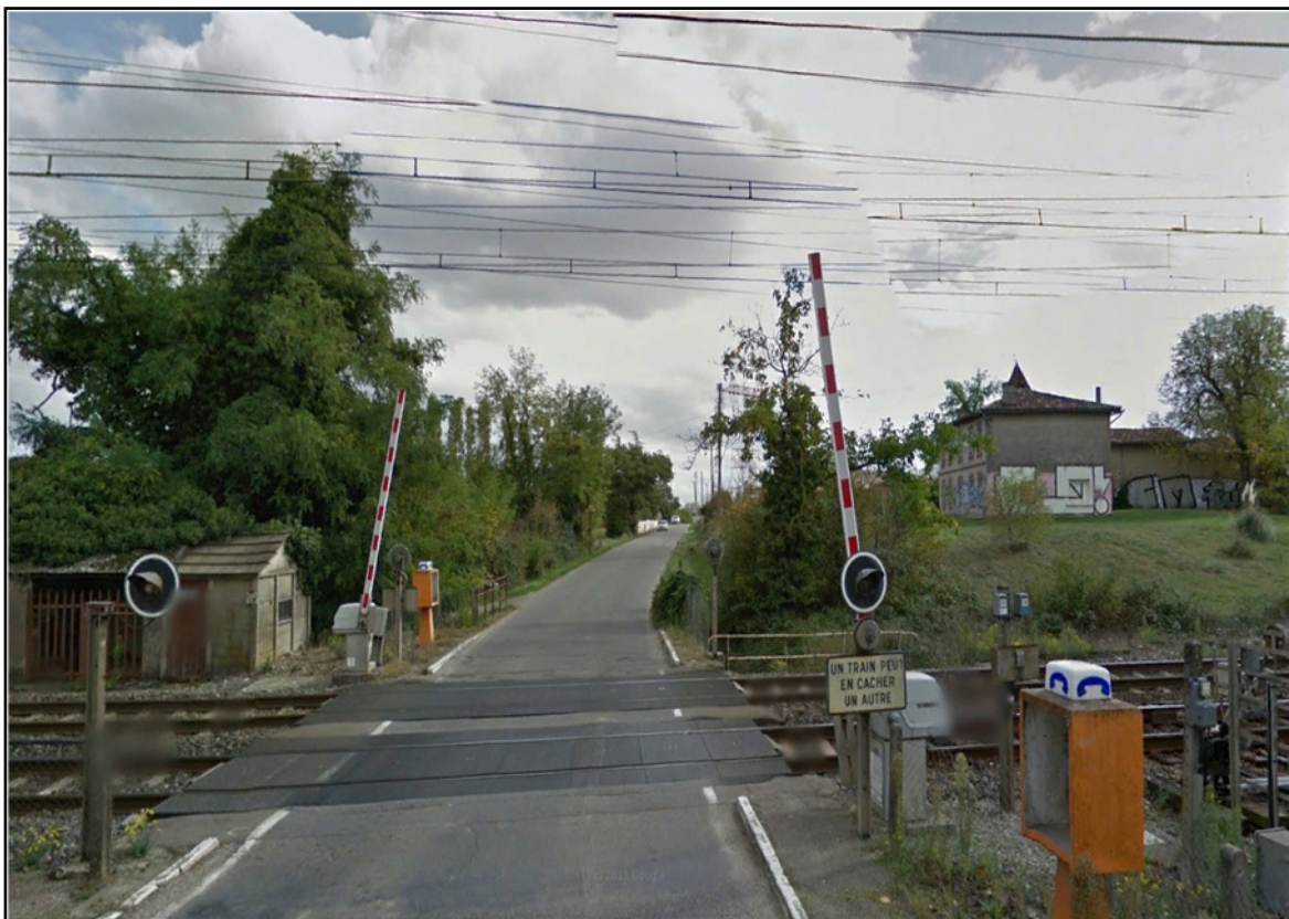
Figure 6 : Le passage à niveau n° 169 vu dans le sens de circulation du camion accidenté
