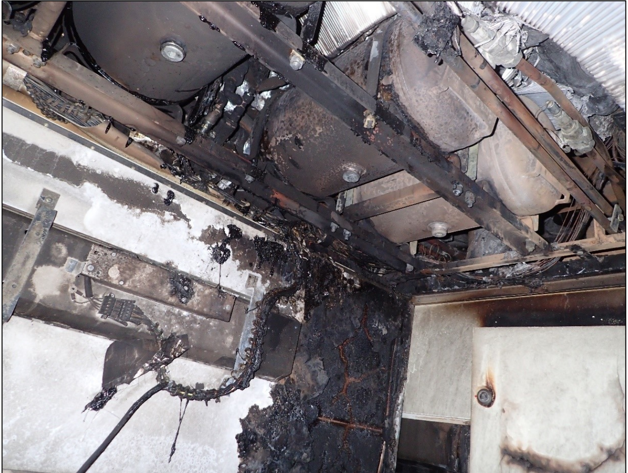
Kuva 3. Dm12-kiskobussin A-pään vaurioita yksikön sisältä eteisen katosta. (Kuva: OTKES)
