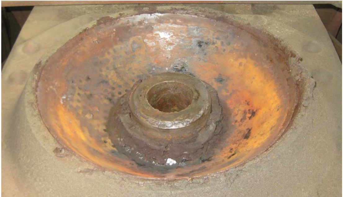
Kuva 12. Vaunun kulkusuunnassa ensimmäisenä suistuneen telin telikeskiö oli kuiva ja hieman ruosteinen.
