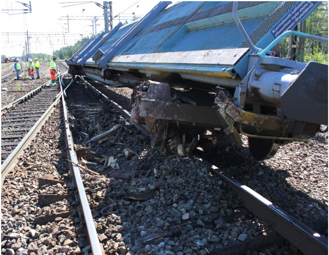
Kuva 6. Vaunulle ja radalle aiheutuneita vaurioita. Kuva on otettu raivaustöiden yhteydessä sen jälkeen kun kyljelleen kaatunut vaunu oli nostettu takaisin pystyyn.
