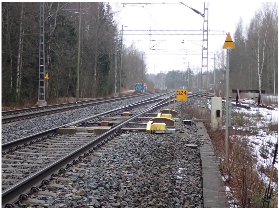
Kuva 3. Vaihde V324 sijaitsee noin kaksi kilometriä Hyvinkään aseman pohjoispuolella. Vaihde on käännetty sivulle johtavaan asentoon kuten vaaratilanteen tapahtuessa.
