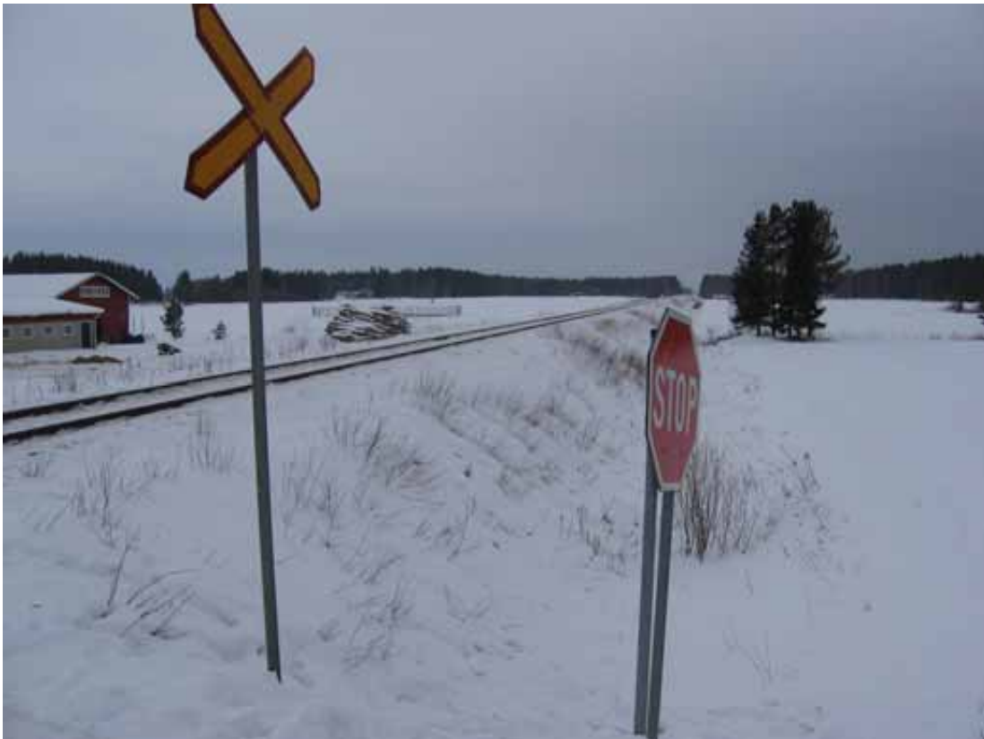
Kuva 6. Näkemä STOP-merkiltä kiskobussin tulosuuntaan.
