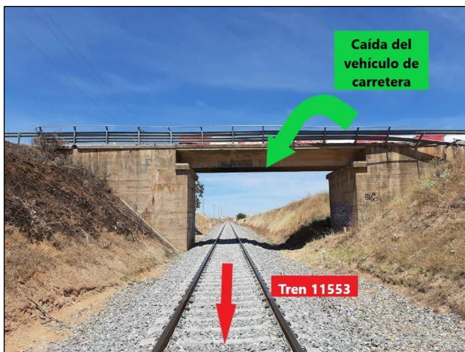
Imagen 10 Vista del paso superior desde el lado Zamora. Se aprecian los daños en el SCV por la caída del vehículo
