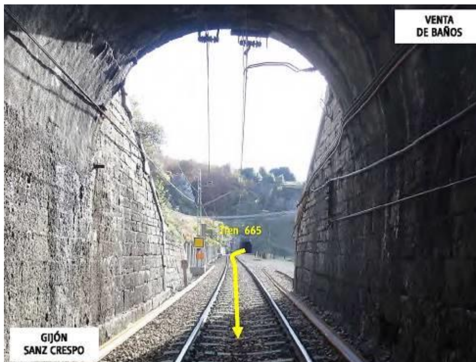
VISTA DESDE EL INTERIOR DE LA BOCA SUR DEL TÚNEL Nº 15 "CANTO DEL ESTILLERO". Fuente Renfe
