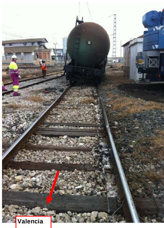
Zona del descarrilamiento (Fuente: Transfesa Rail)
