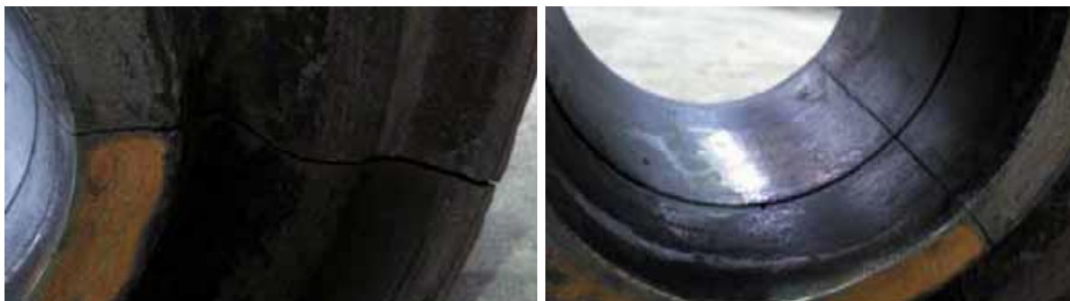
Grieta de la rueda derecha del segundo eje del primer bogie (fuente: ETSII Madrid)
