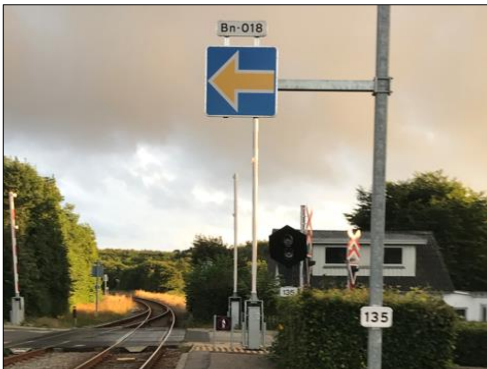
Foto 10. Slukket overkørselssignal på Bedsted station (Thybanen) efter indførelse af ETCS. Foto taget af HCLJ i juli 2021.
