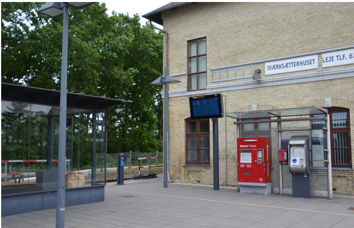
Foto 1 Gavlen af stationsbygningen med informationsskærm og billetautomater
