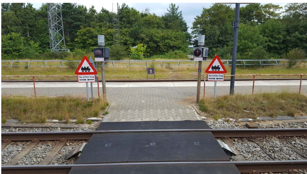
Perronovergangen fem dage efter ulykken. De "nye" færdselstavler skal normalt stå før det spor, de dækker.
